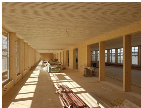
Éléments de toiture préfabriqués sur 3 appuis.
