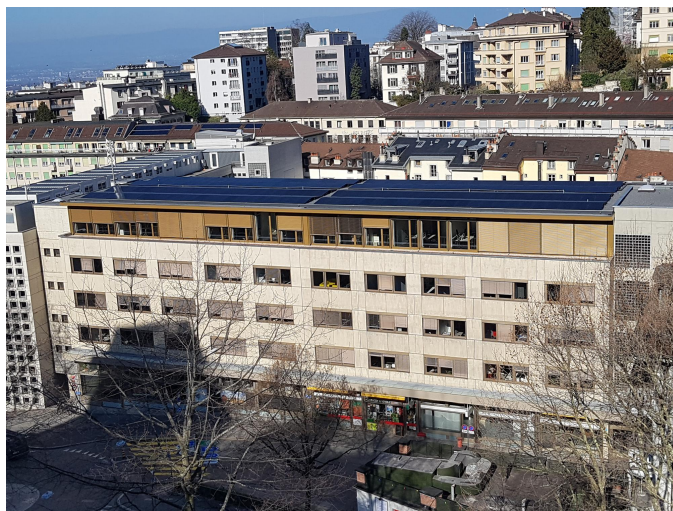
Façade Sud-Est du bâtiment
