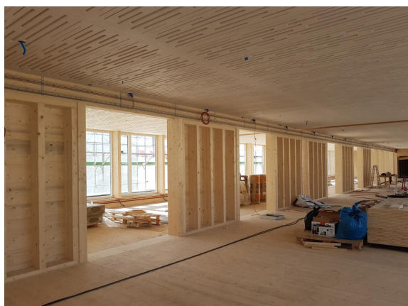
Éléments de sol préfabriqués sur un podium en construction métallique.
