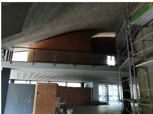
Mezzanine intérieure : zone Nord-Ouest – Dalle BA sur poteaux métalliques.
