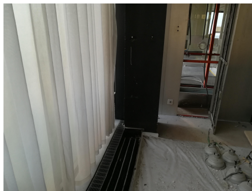
Renforcement de l'encastrement du pied des poteaux afin de minimiser l'intervention sur les structures visibles.
