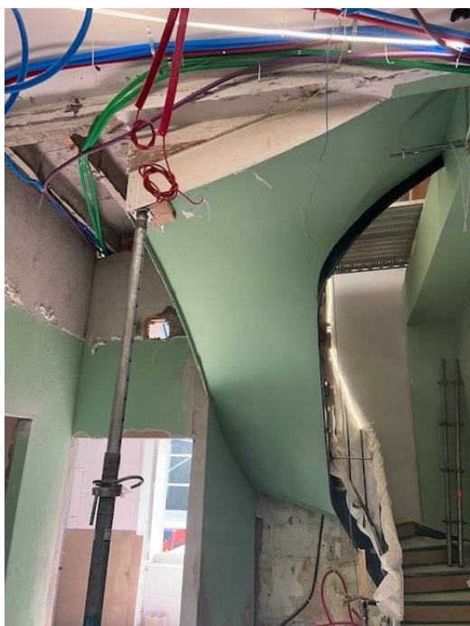
Conservation et stabilisation d'un escalier métallique
