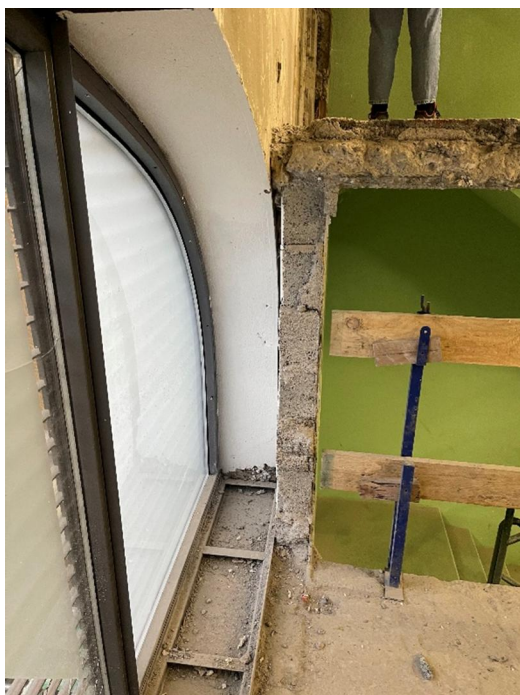
Mise en valeur d'ouvertures existantes tout en conservant des niveaux de dalles existantes
