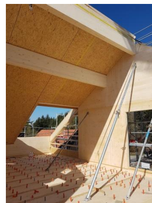
Superstructure et charpente de toiture en bois
