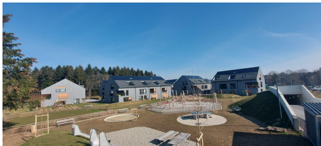
12 nouveaux bâtiments, nouveau parking souterrain, cages d'escalier béton et planchers mixtes bois-béton
