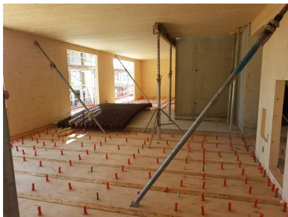
Cage d'escalier en BA, superstructure en bois
