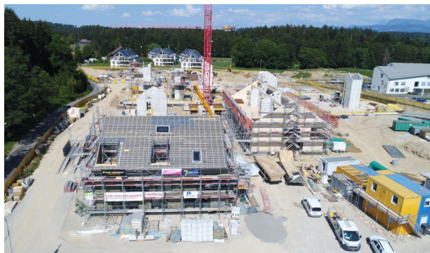
Réalisation du parking et sous-sol partiels des bâtiments. Misapor sous les fondations.
